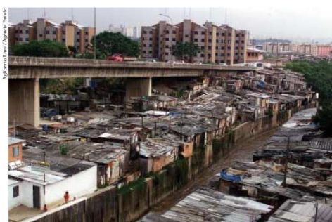
Favela Tiquatava, na marginal Tietê, sob o viaduto General Milton de Souza.
